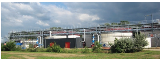
Fot. 2. Oczyszczalnia w Epe w Holandii
