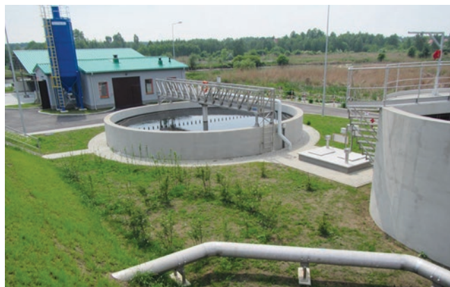
Fot. 5. Widok na zagęszczacz osadu i budynek odwadniania i higienizacji osadu
