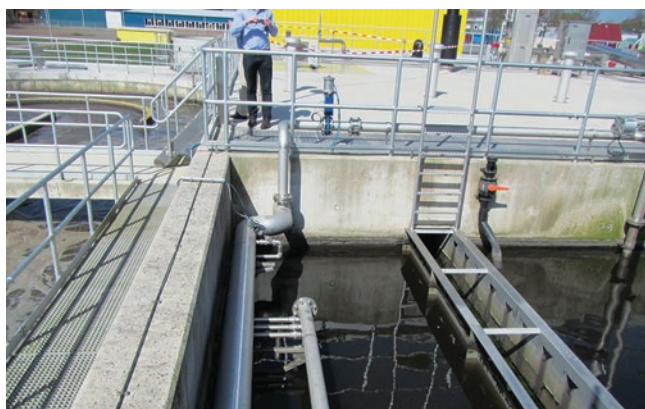
Fot. 3. Vroomshoop: z lewej klasyczny reaktor, z prawej reaktor Nereda®
