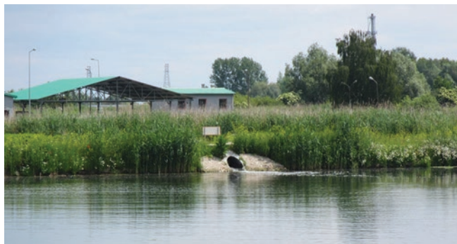
Fot. 7. Wylot ścieków oczyszczonych
