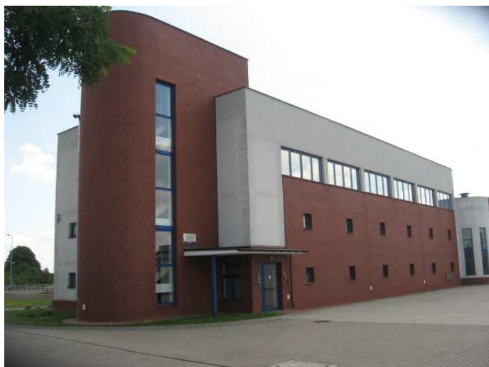
Fot. 2 SUW- Gruszczyń po przeprowadzonej w latach 2004-2007 modernizacji
