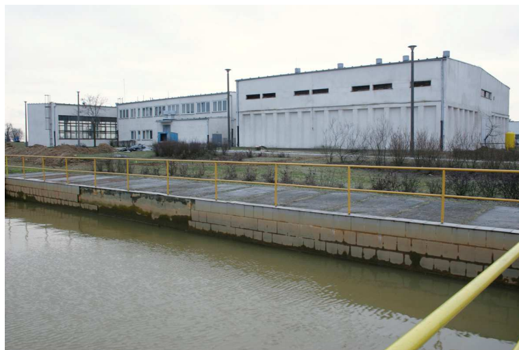
Fot. 1 SUW- Gruszczyn przed modernizacją
