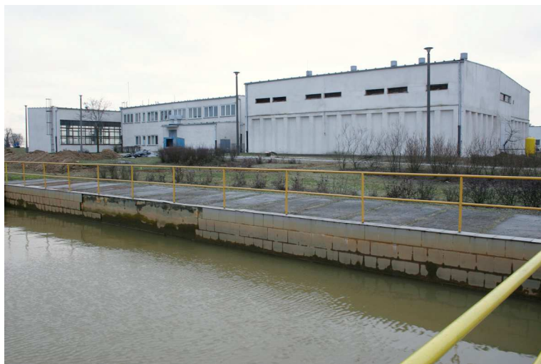
Fot. 1 SUW- Gruszczyn przed modernizacją
