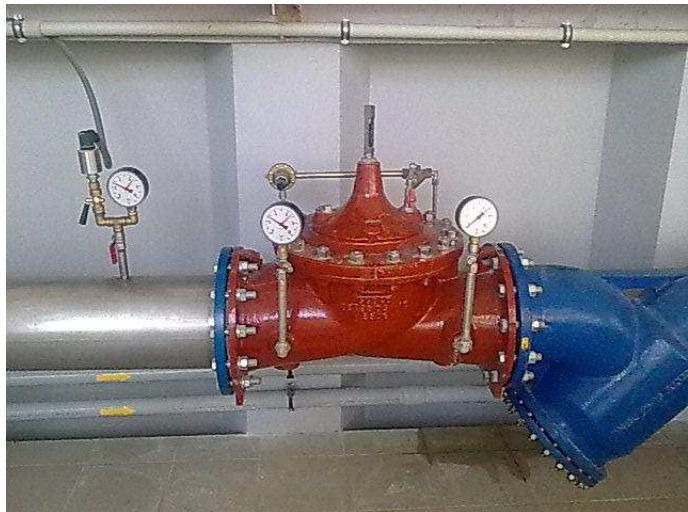
Fot. 4 Zdemontowany zawór obniżający ciśnienie dla strefy dystrybucji Swarzędz.
